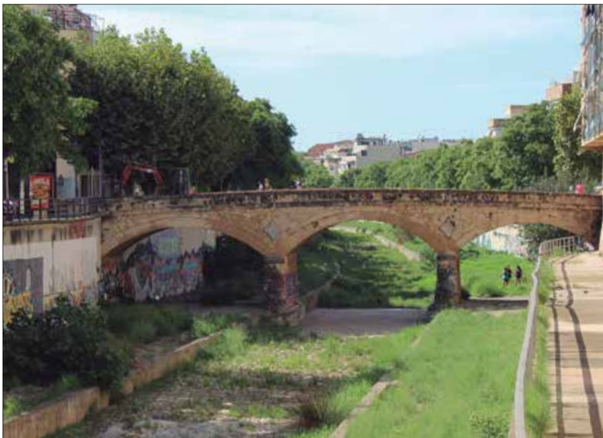
Les obres s'han iniciat amb l'enrajolament del Pont de França. ✦ LA FURA
