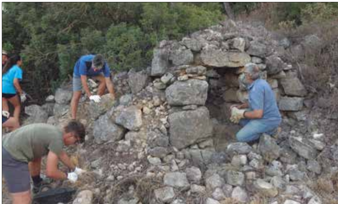
Restauració d'una barraca de pedra seca al camp de treball de Subirats de 2021.
