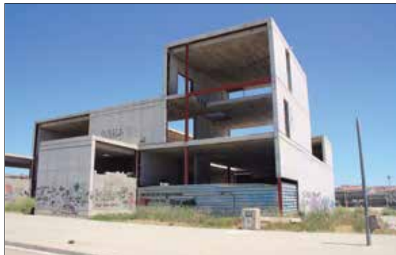
L'edifici ha de ser reformat i rehabilitat. ✱ GERARD VIVES - ACN
