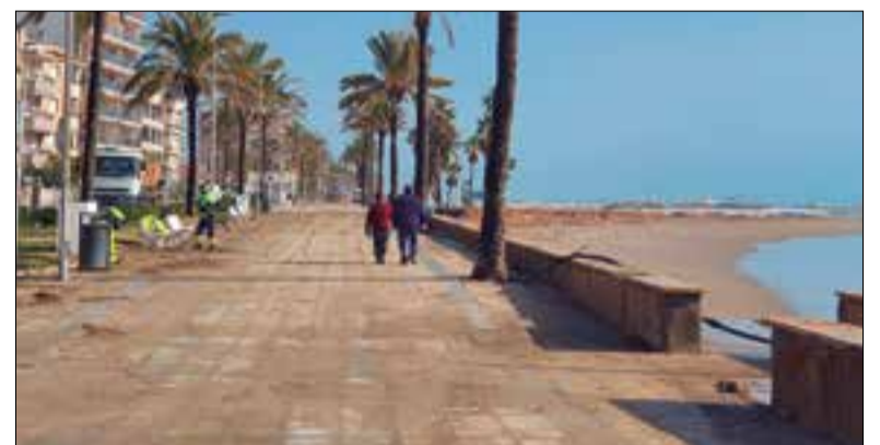
Passeig marítim amb l'aigua del mar arran després d'un temporal.
