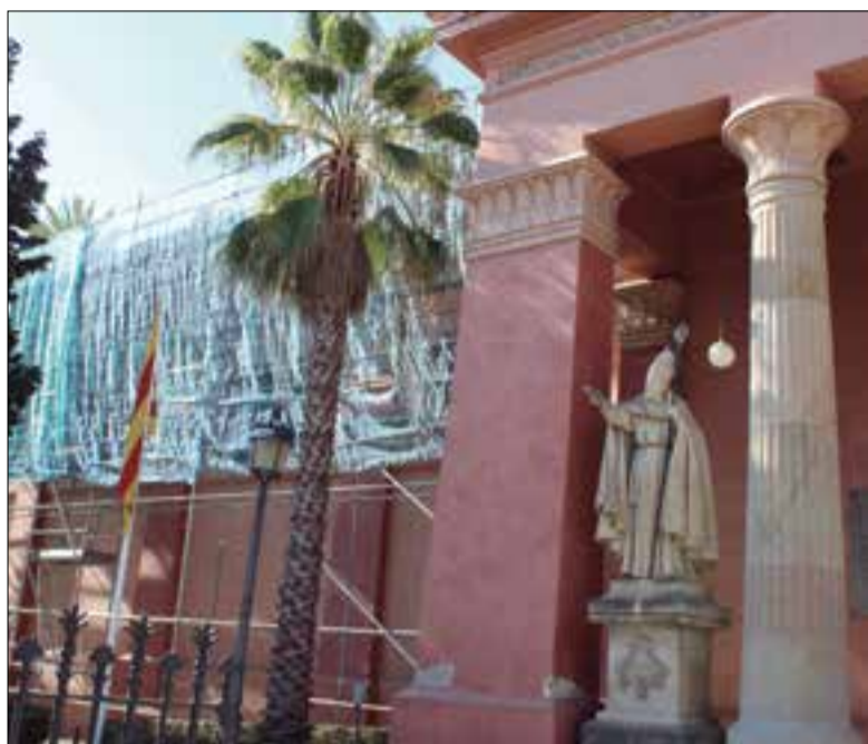
S'estan fent tasques per reparar els esgrafiats de la façana. ✦ LA FURA
