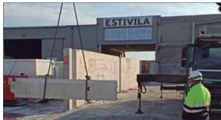
S'estan retirant elements de l'estructura anterior. ✦ PORTS
