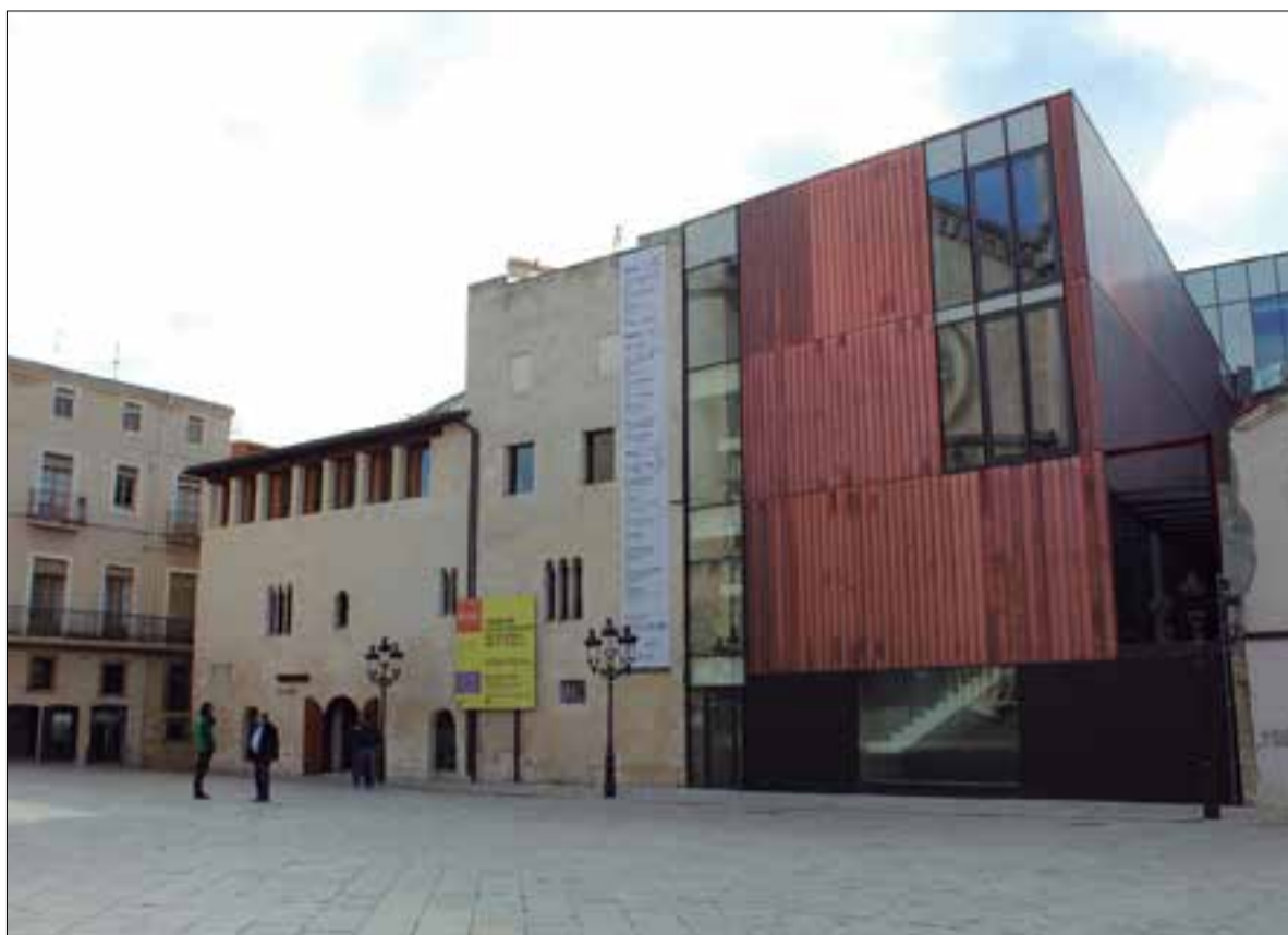
El nou edifici incorpora les restes del celler trobades durant l'enderroc de Cal Pa i Fígues. ✱ LA FURA
