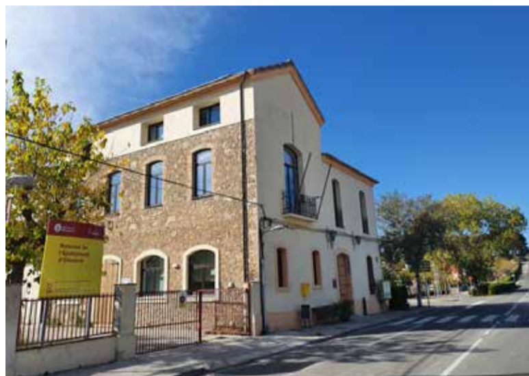
L'edifici consistorial ha estat dos anys d'obres. ✱ AJUNTAMENT
