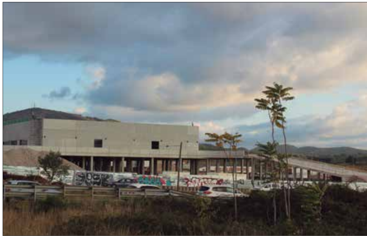
Les obres del parc comercial de Vilanova avancen a bon ritme. ✖ LA FURA
