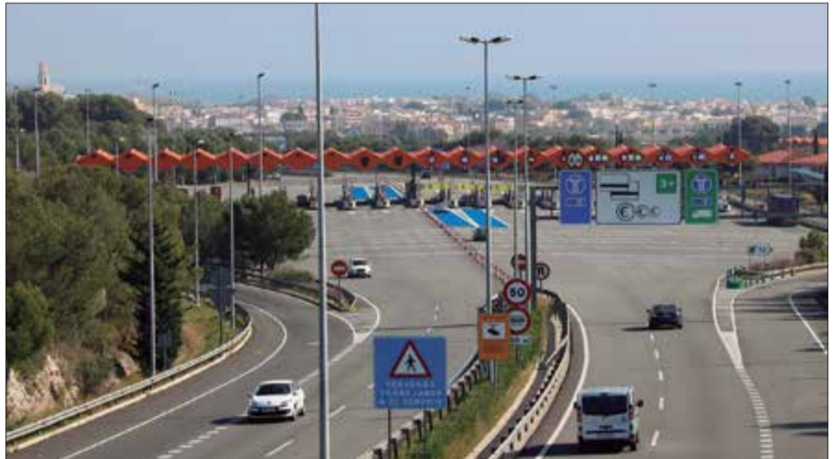
Peatge de Cubelles, a l'autopista Pau Casals. ✱ GEMMA SÁNCHEZ - ACN
