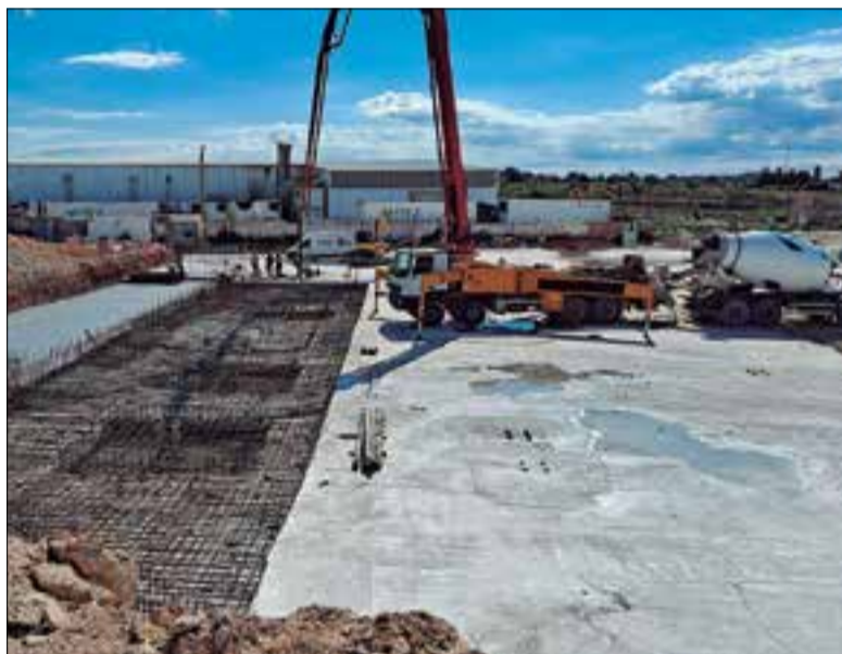
Les obres del parc comercial avancen a bon ritme. ✦ AJUNTAMENT
