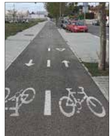
Carril bici ja construït. ✱ AJUNTAMENT
