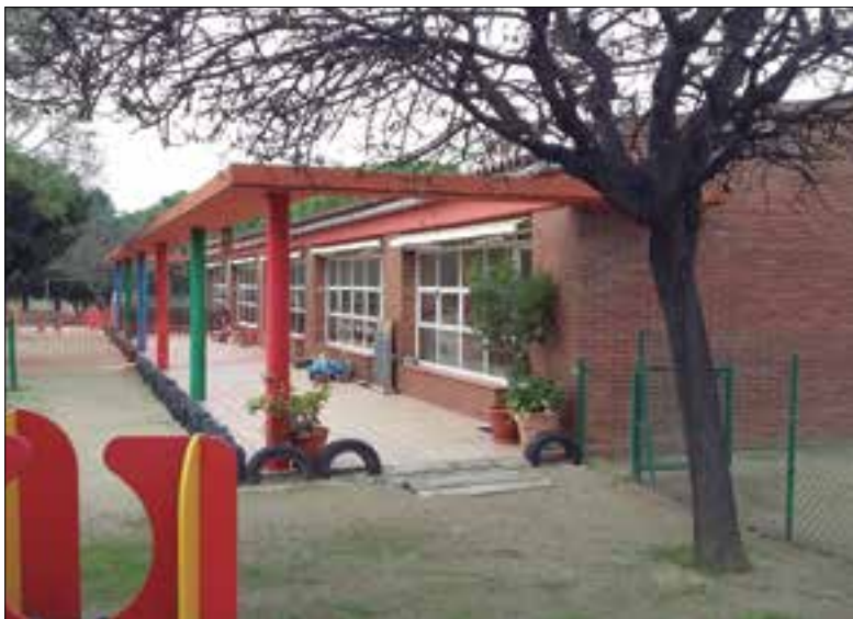
Escola bressol El Puig del Vendrell. ✱ ARXIU LA FURA
