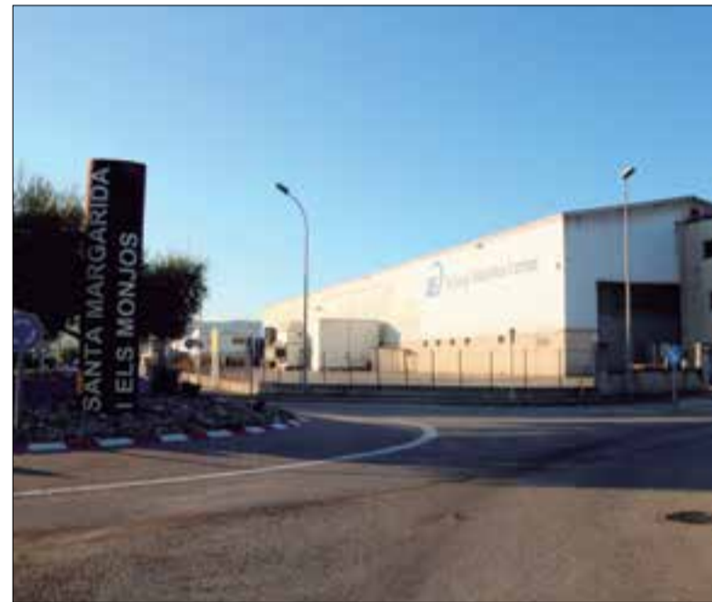
El robatori d'un cable de coure ha provocat la decisió. ✳ GEMMA SÁNCHEZ - ACN
