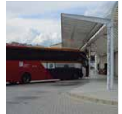
Estació d'autobusos. * LA FURA
