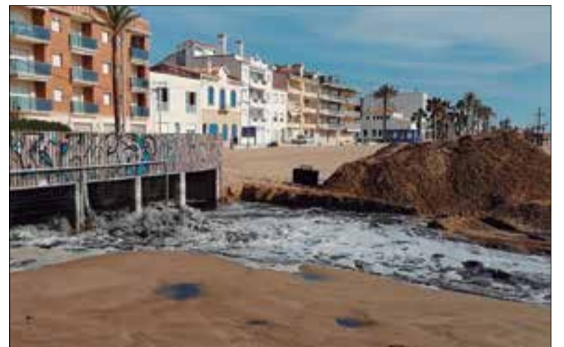
Desguàs de l'aigua pluvial per sobre de la sorra de la platja. ✱ AJUNTAMENT
