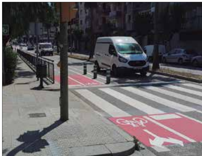
Carril bici a la ronda Ibèrica, restant un carril de circulació. ✦ AJUNTAMENT
