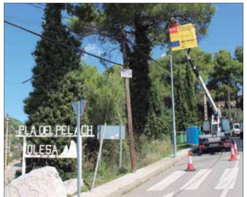
A la urbanització Pla del Pèlag s'han canviat 256 lluminàries. ✪ LA FURA
