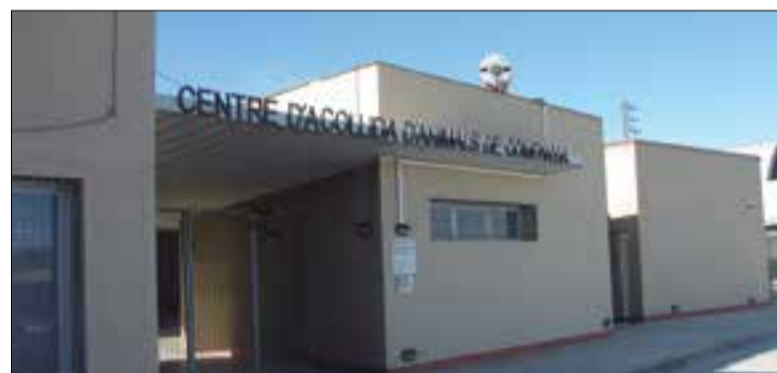
CAAD ubicat al costat de la planta de triatge de brossa. ✱ MANCOMUNITAT
