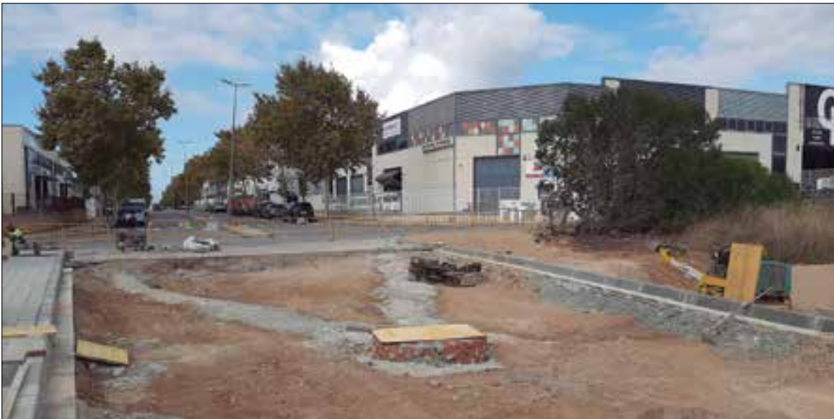
Obres a la ronda Ibèrica per connectar els dos polígons industrials. ✦ AJUNTAMENT DE SANT PERE DE RIBES
