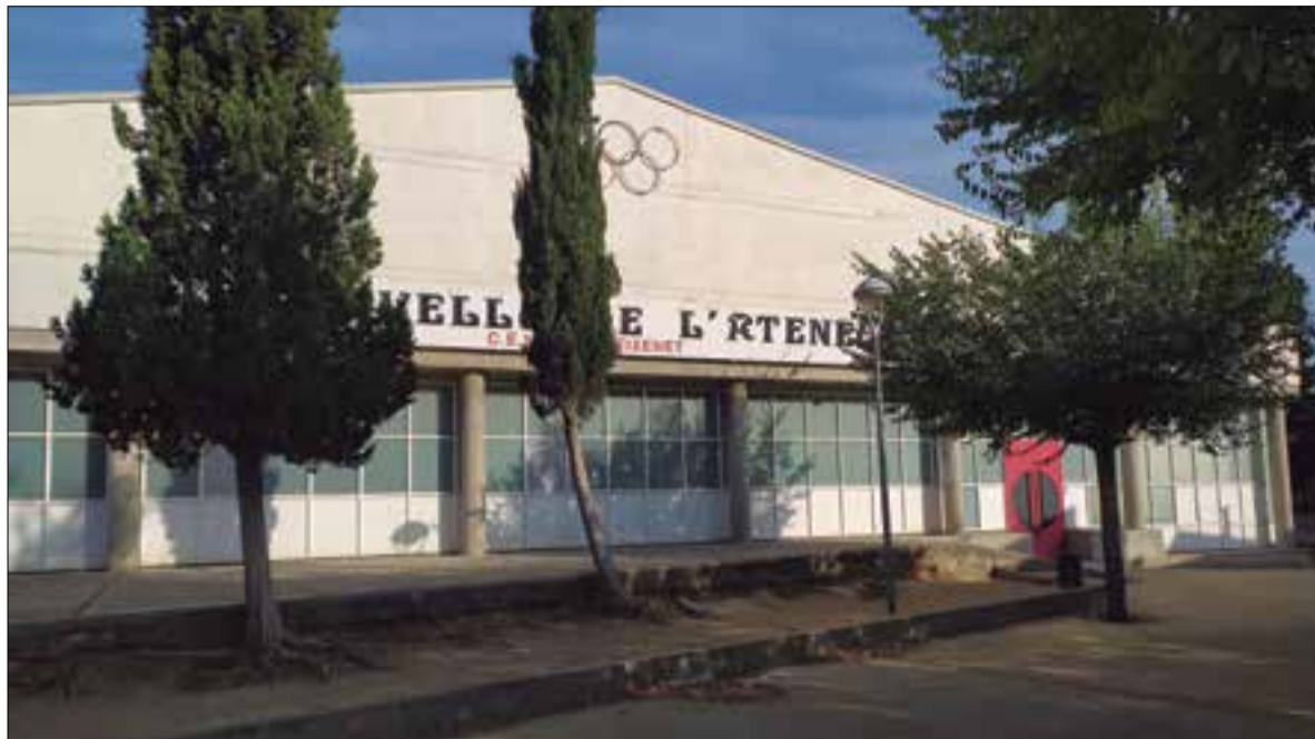
La primera fase de les obres se centrarà en la renovació de tota la coberta de l'edifici. ✱ LA FURA
