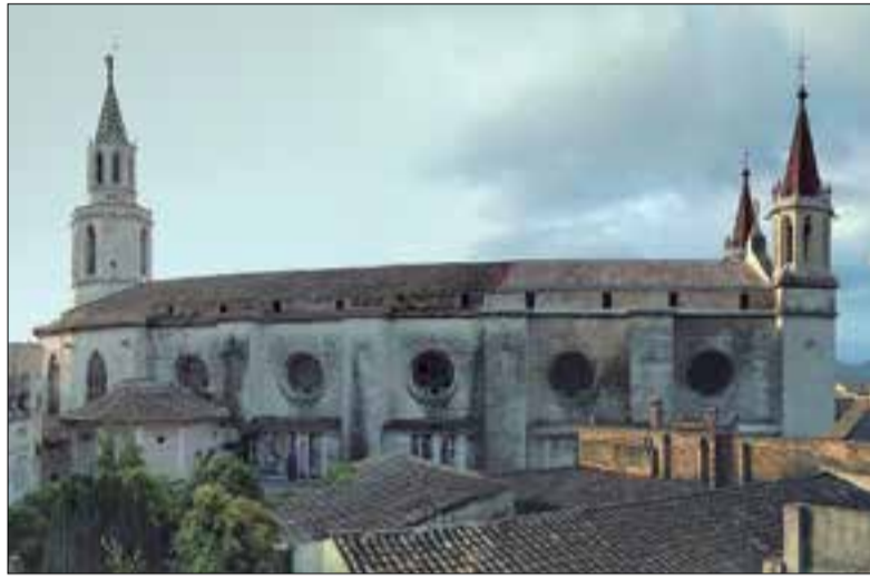
Ja s'ha finalitzat el primer tram de les obres, en queden tres. ✳ SANTA MARIA 2020
