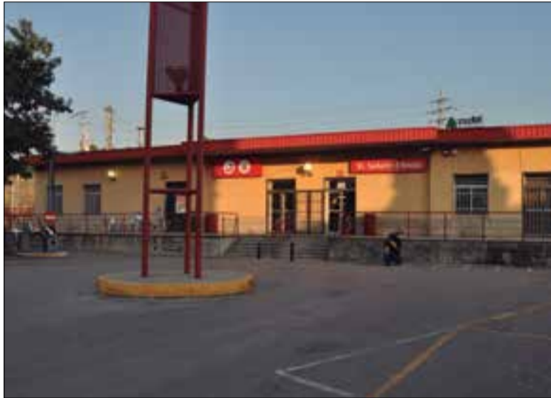
El temps que durin les obres, la plaça de l'estació de Sant Sadurní es rehabilitarà.
