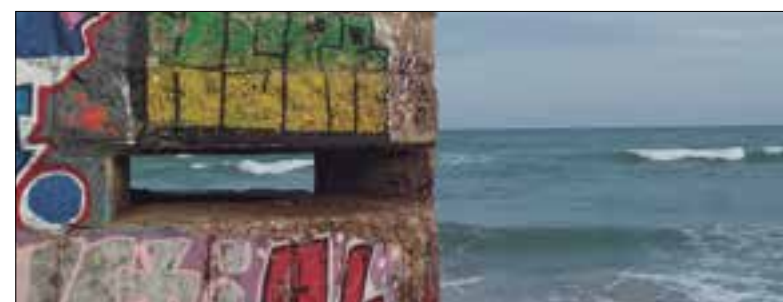
Niu de metralladores a la platja del Far. ✦ LA FURA
