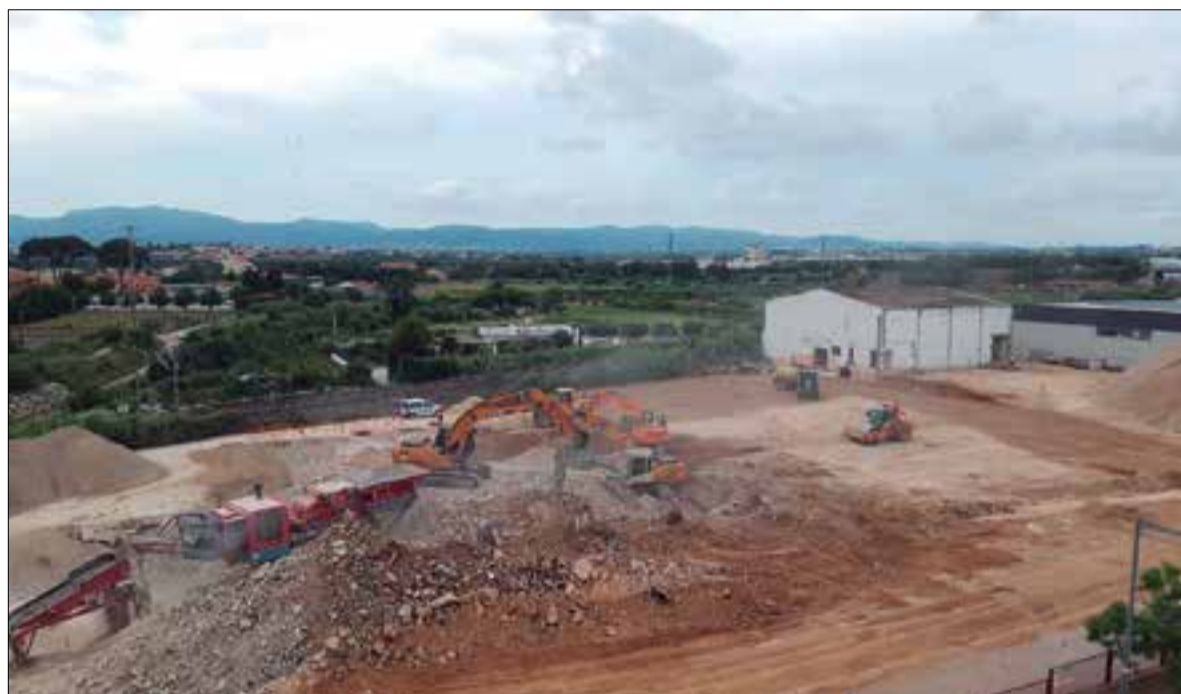
La pols de les obres es filtra a les cases i seria la causa dels problemes de salut. ✱ MARIA LOURDES GARCÍA
