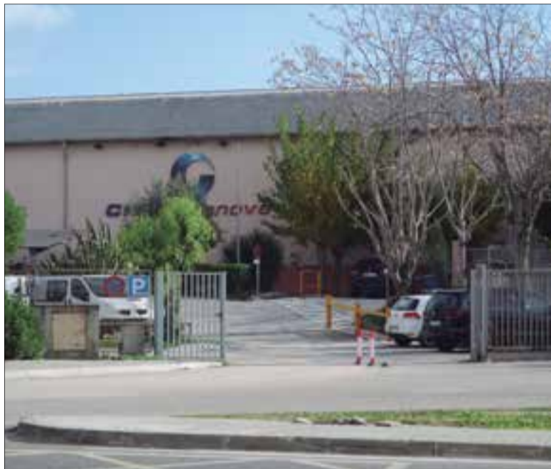
Les instal·lacions de Componentes estan en sòl urbà. ✖ AJUNTAMENT
