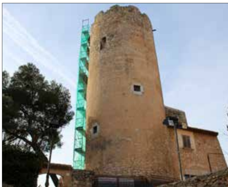
En aquesta primera fase s'ha estabilitzat l'edifici i s'han arranjat les parets.
