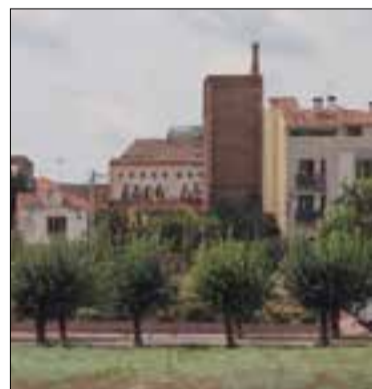
La torre de La Fassina es mantindrà.
