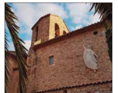
L'església en procés de reparació.
