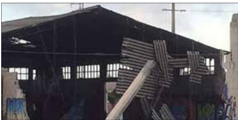
Ara s'està destruint l'antiga empresa Paviments Betón. ✱ CCOO
