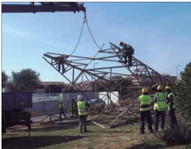
Operaris desmuntant una de les torres. ✱ ACN
