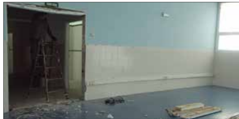
El centre es construeix a les antigues instal·lacions del gimnàs municipal.
