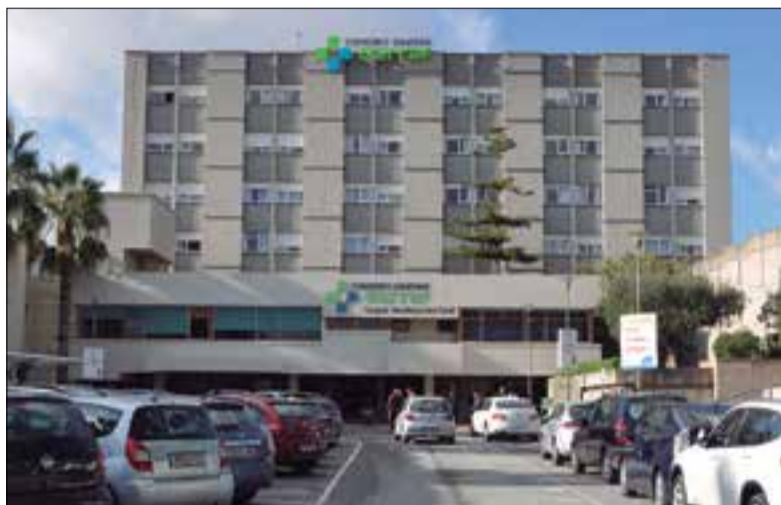
Hospital Sant Camil. ✱ CONSORCI SANITARI DEL GARRAF
