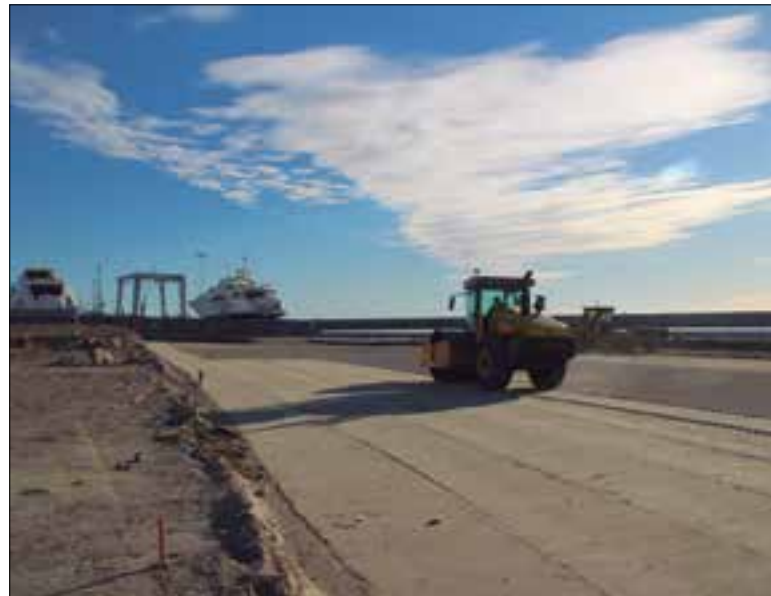
Excavadora aplanant els terrenys de l'àrea tècnica. ✦ PORTS DE LA GENERALITAT
