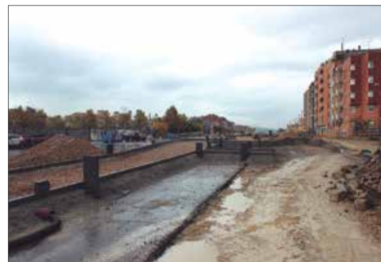
Zona del carrer Papiol, emplantanegada per les obres. ✱ LA FURA
