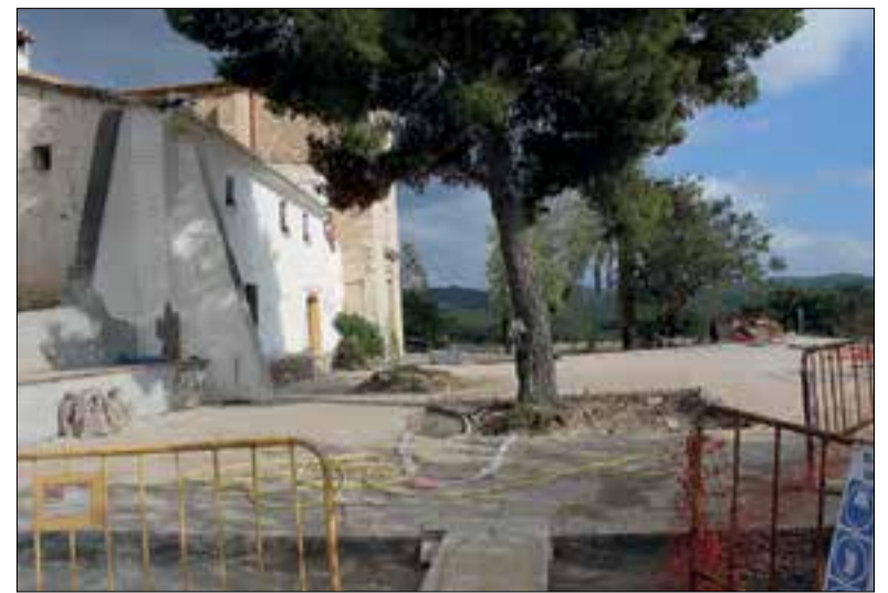
El nou enrajolat, de tons terrossos, està quasi enllestit. ✦ LA FURA
