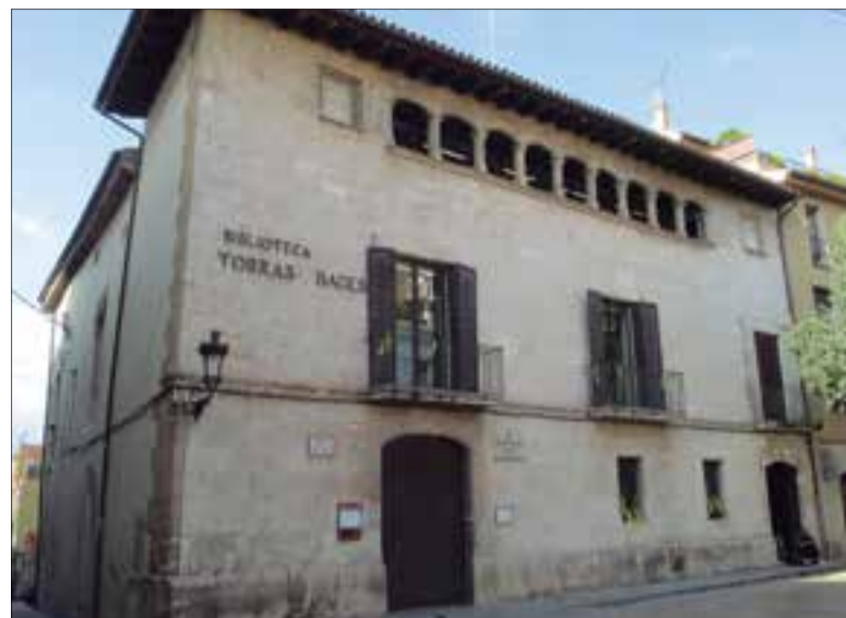
Biblioteca Torras i Bages. ✱ LA FURA
