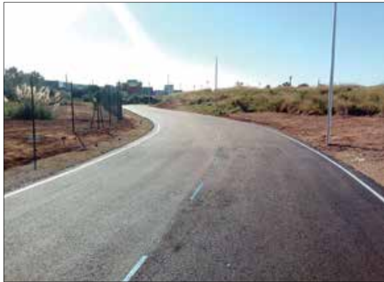
Circuit asfaltat i acabat de pintar. ✦ AJUNTAMENT
