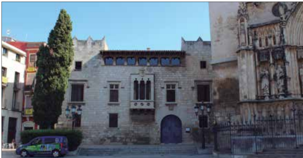
El Palau Baltà, d'origen medieval, és un dels edificis que obriran les seves portes. ✱ LA FURA
