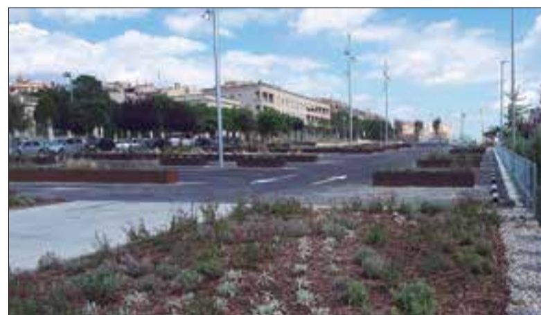
Nou aparcament sobre la cobertura de la via. ✱ LA FURA
