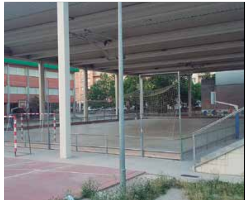
Pista coberta del pati de l'escola pública Pau Boada. ✱ LA FURA
