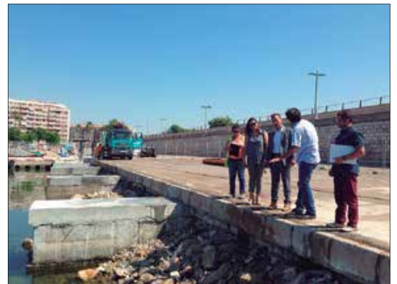
El gerent de Ports, Joan Pere Gómez, acompanyat del patró major de la Confraria de Pescadors, Jaume Carnicer, en una visita a les obres.
