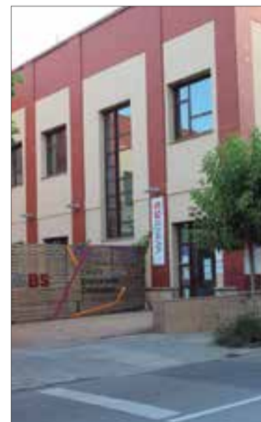
Façana de la WineBS. ✪ LA FURA
