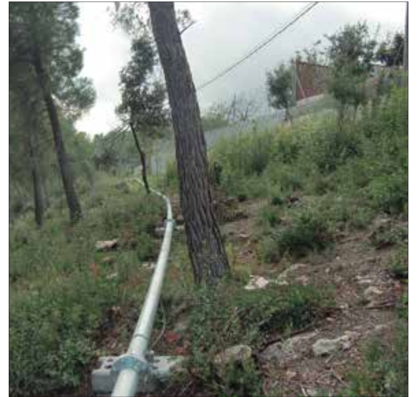
Canonada que va substituir la que tenia fuites. ✱ AGUAS MARTIVELL SCCP
