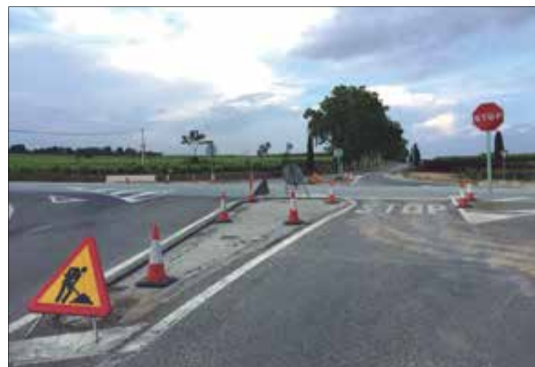
Els treballs permetran millorar la seguretat en una intersecció molt perillosa.
