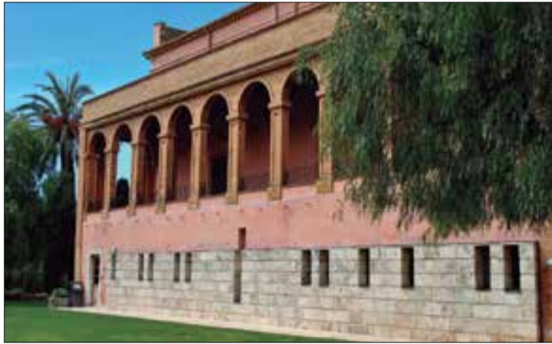
Galeria exterior de la masia Cabanyes.
