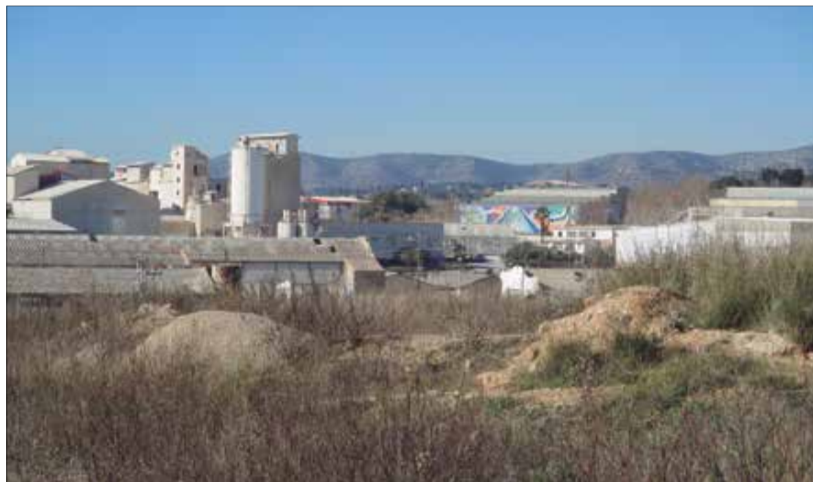
La revitalització de la degradada zona del polígon Masia d'en Barreres passa pel parc comercial. ✦ LA FURA
