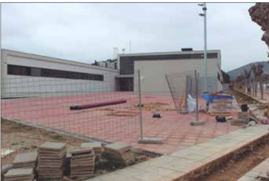
Les obres del CAP de Ribes estan avançades. ✖ LA FURA
