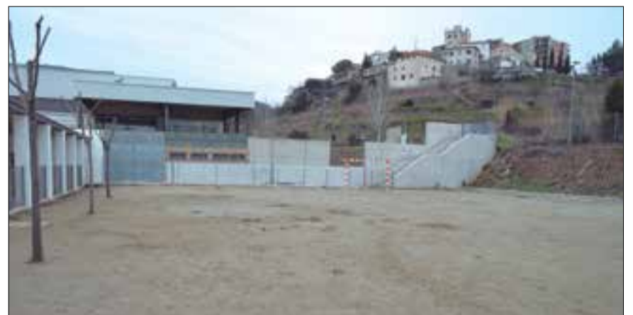
Zona per on s'ha d'ampliar l'IES Vall de Mediona. ✖ GEMMA ISANTA
