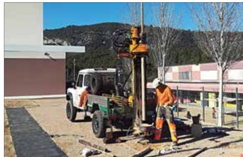
Tècnics fent les primeres prospeccions al terreny on es construirà el pavelló.
