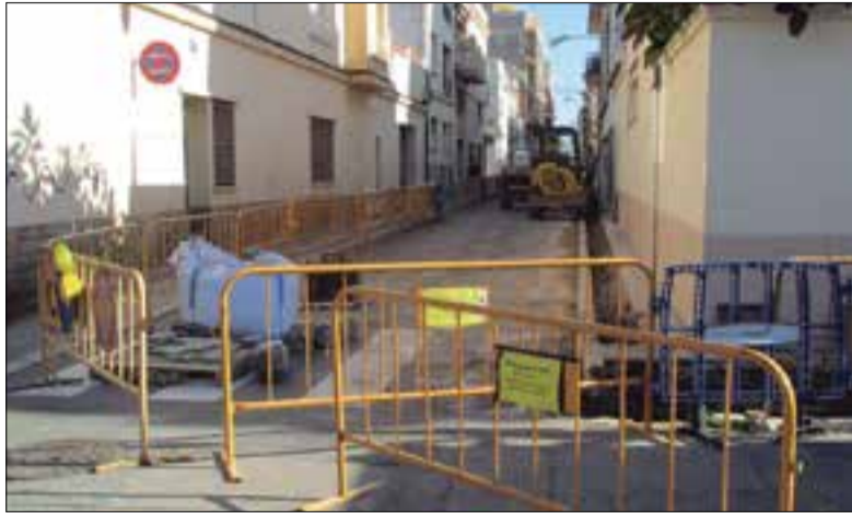
Obres al carrer Soler i Morell, a tocar de la rambla Samà. ✳ LA FURA
