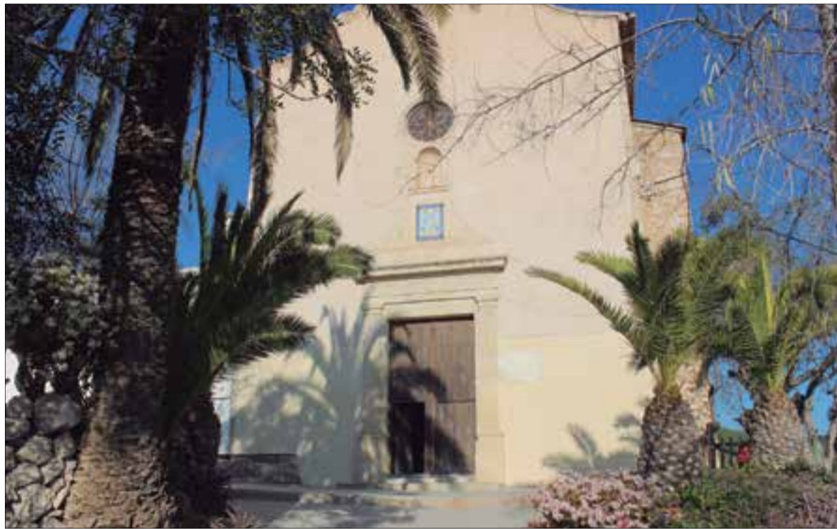
Façana de l'ermita de Sant Pau. ✦ LA FURA
