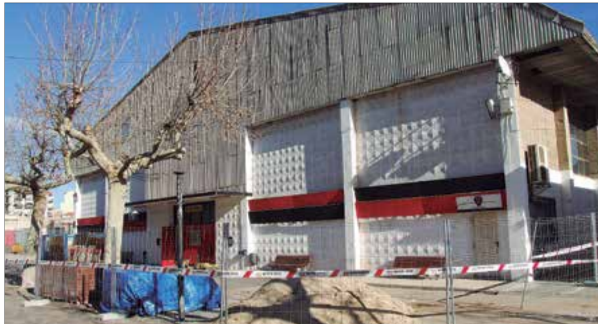
Exteriors del pavelló, en obres. ✱ AJUNTAMENT
