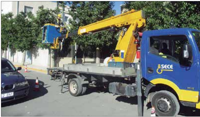
Treballs de substitució de les llumeneres a Moja. ✱ AJUNTAMENT D'OLÈRDOLA
