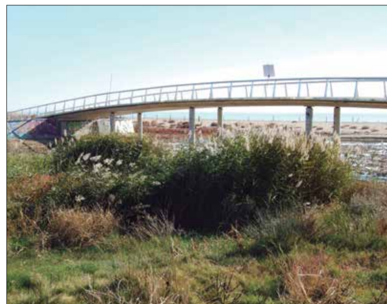
El pont que creua la riera de la Bisbal fa 80 m de llargada. ✦ AJUNTAMENT
