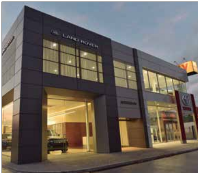
Les noves instal·lacions s'ubiquen a l'avinguda de Tarragona. ✱ LA FURA
