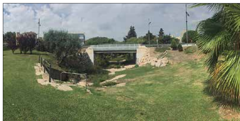
La primera acció se centrarà en el torrent de la Casa Nova. ✱ AJUNTAMENT
