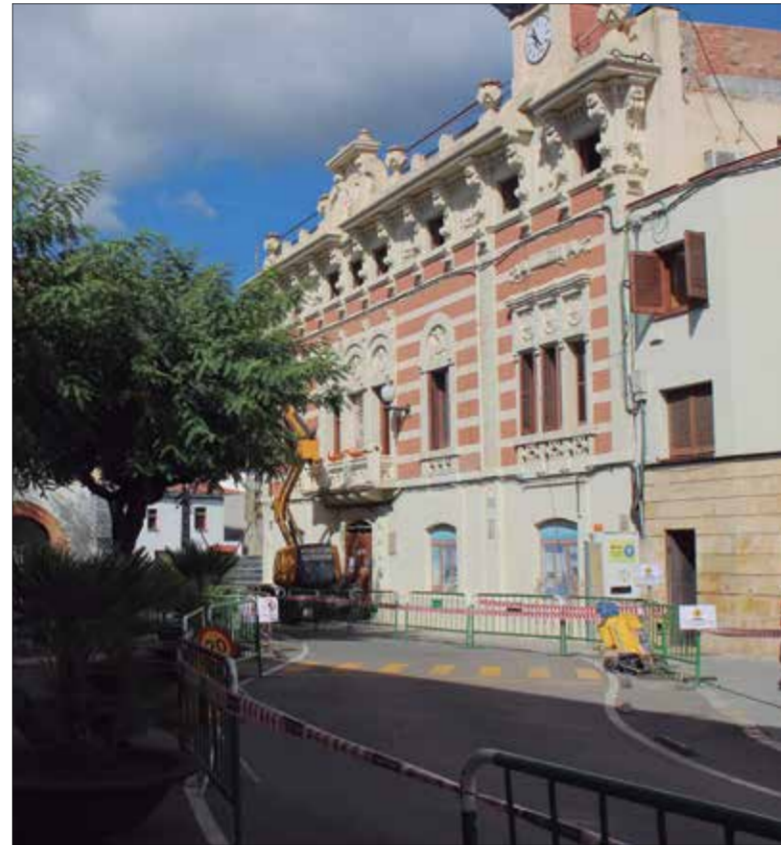
Les obres duraran un mes i mig, durant el qual es tallarà el trànsit. ✦ LA FURA
