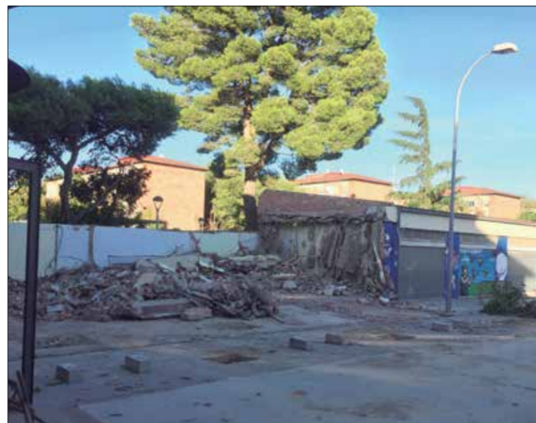
Ja s'ha enderrocat una part de l'edifici que s'interposa entre les places Pau Casals i Dr. Bonet. ✱ AJUNTAMENT
