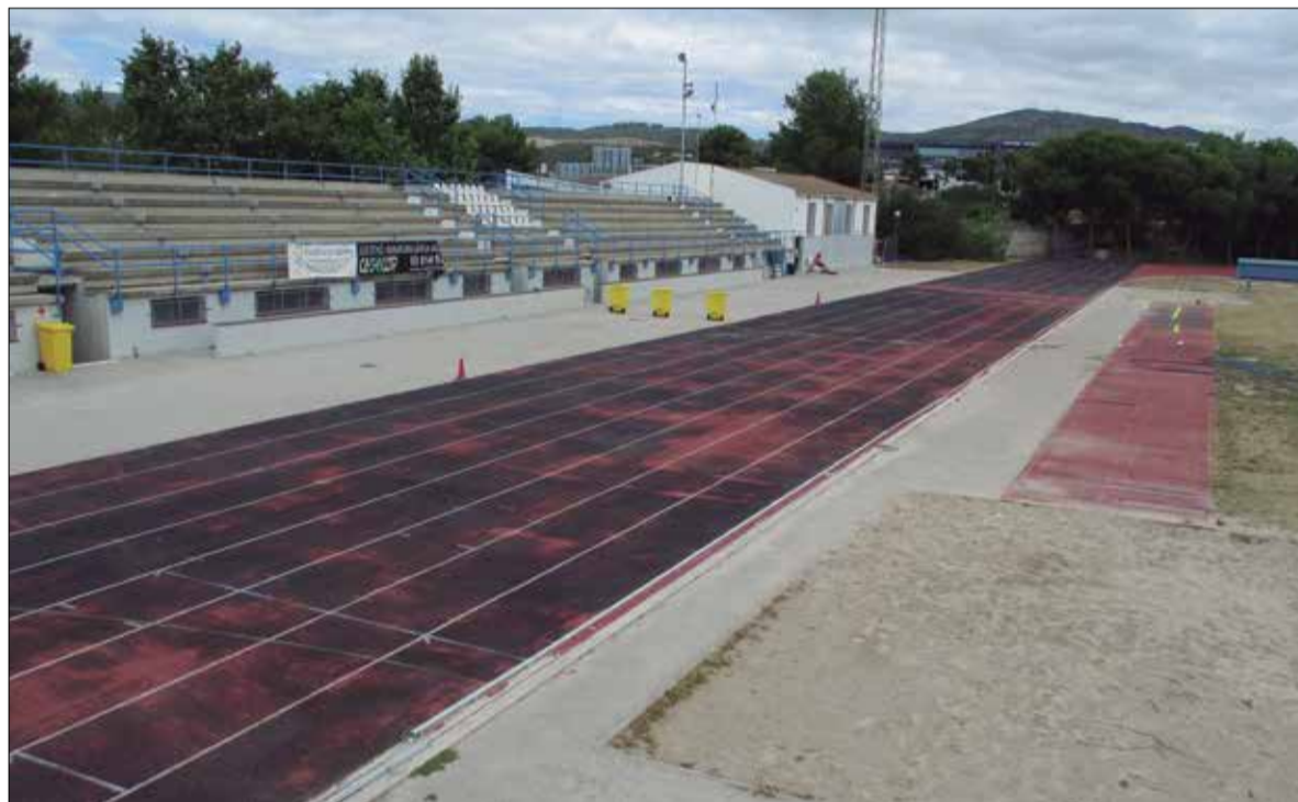
A la recta de la pista d'atletisme li ha saltat la capa de sobre i el cautxú negre de sota queda a la vista. ✱ LA FURA
