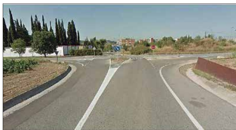
La rotonda millorarà la seguretat en una intersecció molt perillosa.
